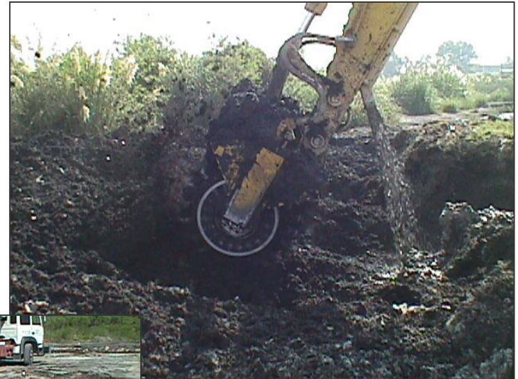
Aplicación de lechada de reactivo de estabilización con rodillo hidráulico.
