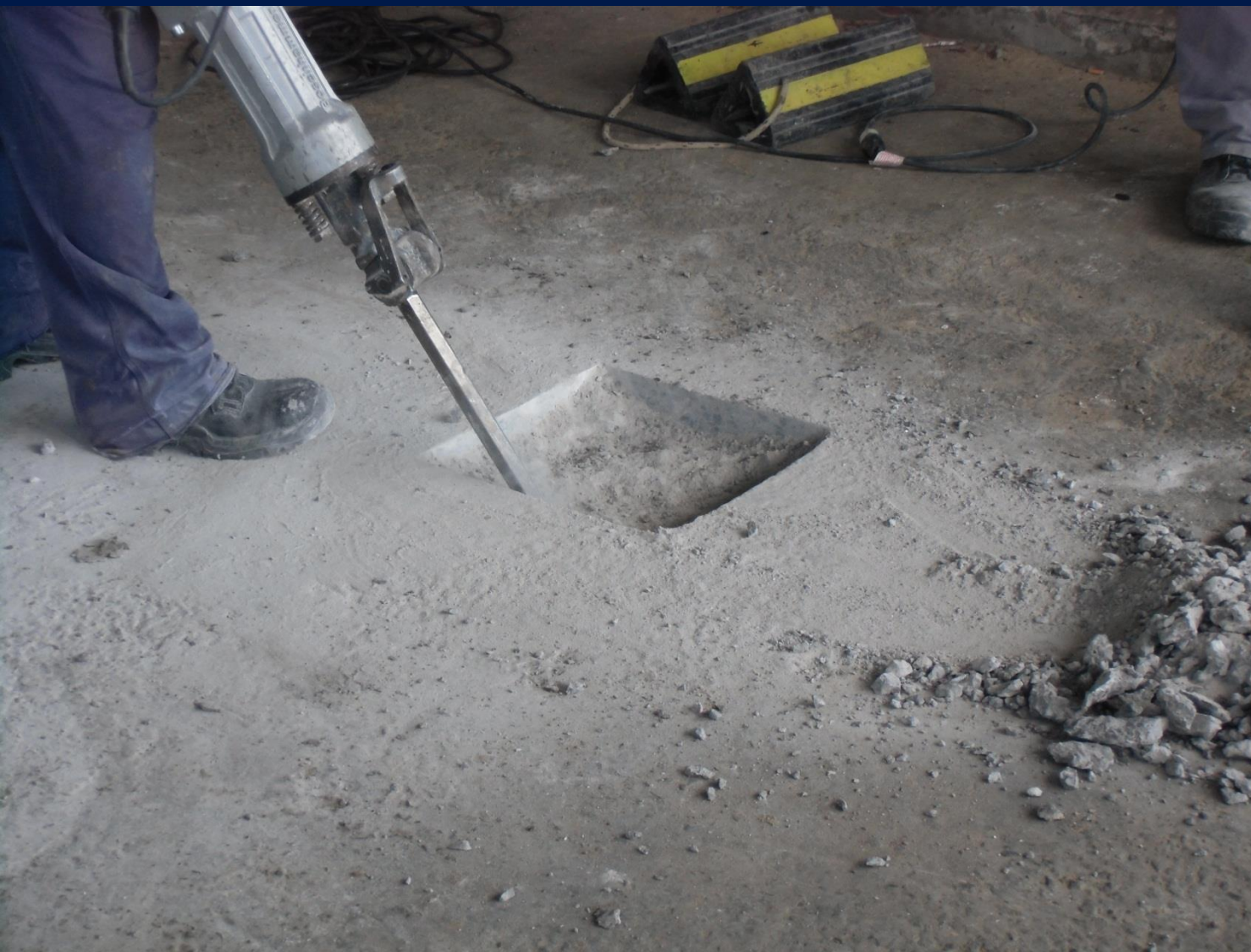
Foto 3 Rotura de hormigón previo a sondeo S3
