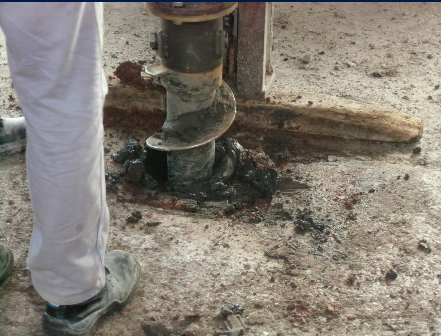
Foto 8 Perforación para Freatímetro F3
