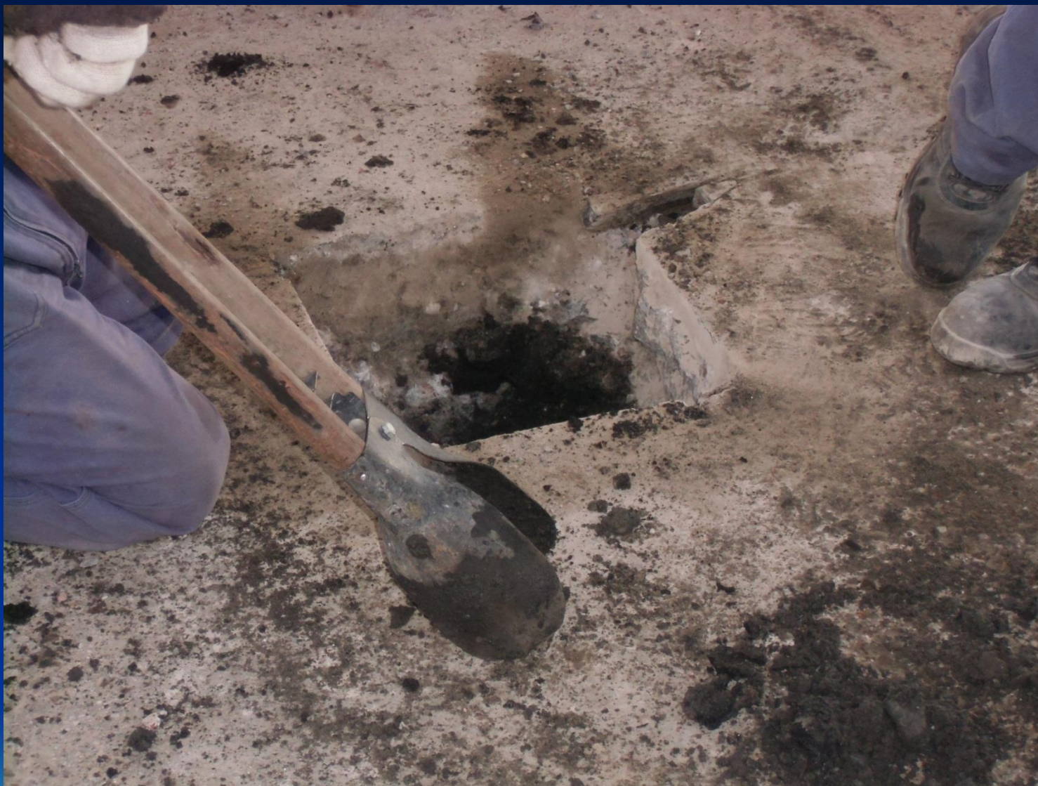
Foto 7 Cateo previo a perforación para Freatímetro F3
