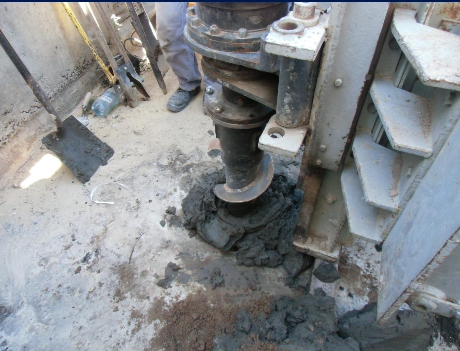
Foto 6 Perforación para Freatímetro F2
